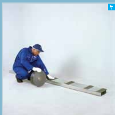
اجرای نوار عایق بر روی استاداها
