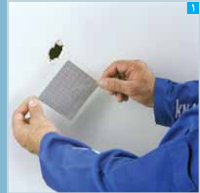
۱ قرار دادن وصله مخصوص پشت چسب دار بر روی محل آسیب دیده
