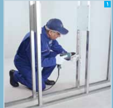
اتصال قطعات نبشی L25 به استادهای مجاور
