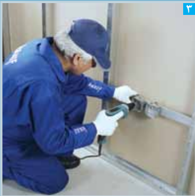
اتصال قوطی برق به سازه پشتیبان
