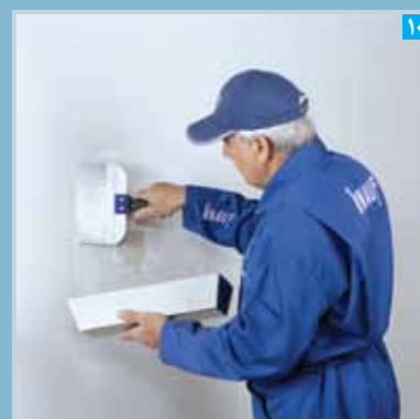
۱۰ بتونه کاری درزها در محل ترمیم (با استفاده از نوار و بتونه درزگیر کناف)
