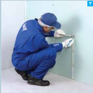
تعیین محل خروجی های تاسیساتی
