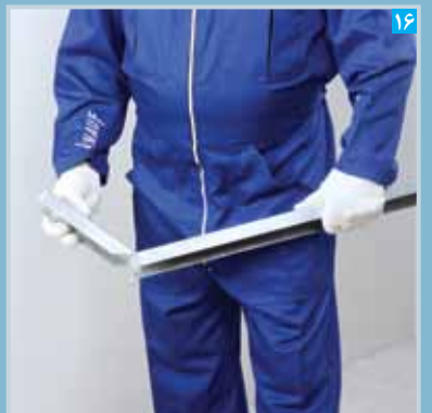
۱۶ خم کردن انتهای رانر نعل درگاه
