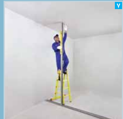
انتقال تصویر رانر کف به سقف (با استفاده از استاد و تراز)
