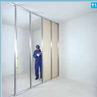
اجرای پنل ها در یک طرف دیوار
