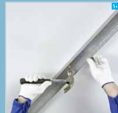
اتصال رانر به سقف با رول پلاگ
