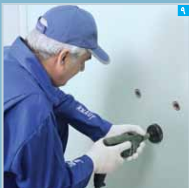
خروجی های تاسیساتی به وسیله گردبر ایجاد می شوند
