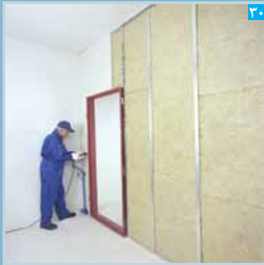
۳۰ پیچ زنی پنل در حاشیه دور چهارچوب
