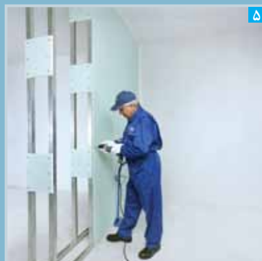
اجرای پنل ها در یک طرف دیوار
