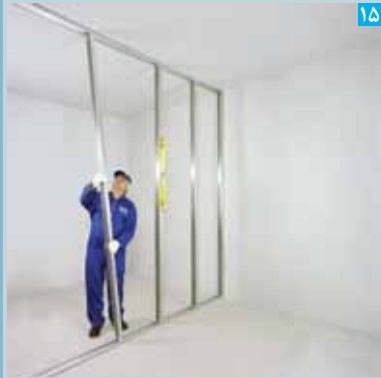
اجرای استاداها (به صورت شاقولی)
