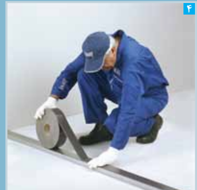
اجرای نوار عایق (یا دو ردیف خمیر سیلیکون) بر پشت جان رانر کف و سقف
