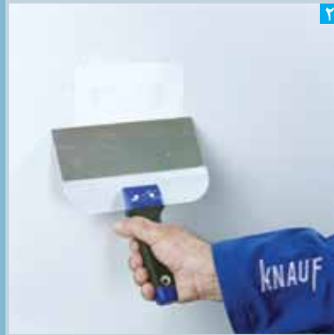
۲ اجرای بتونه بر روی وصله ترمیمی
