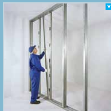
اجرای ردیف دوم استاداها
