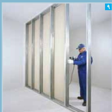
اجرای پنل ها در یک طرف دیوار
