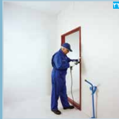
۳۲ پیچ زنی پنل در حاشیه دور چهارچوب و تکمیل پوشش کاری
