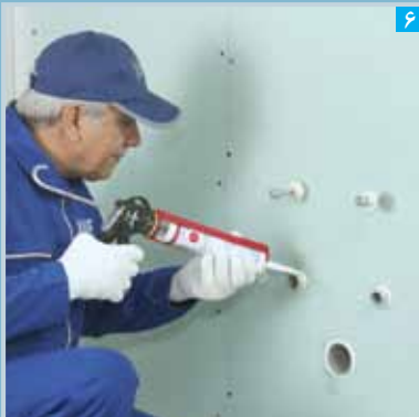
اجرای خمیر درزبند در اطراف خروجی های تاسیساتی
