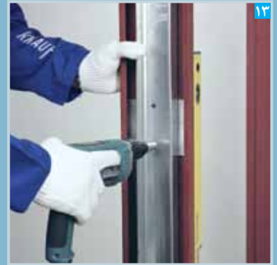
۱۳ چهارچوب توسط پیچ LB در محل صفحات نصب به استاداها متصل می شود
