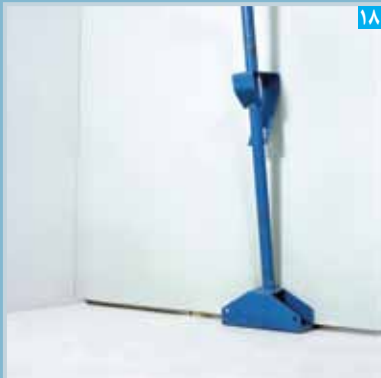
پنل ها به وسیله جک مخصوص به نحوی بر روی زیرسازی قرار می گیرند که یک سانتیمتر با کف فاصله داشته باشند
