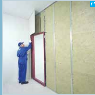
۲۹ اجرای پنل سوم دور چهارچوب پس از عایق گذاری (پنل ها نسبت به سمت اول به صورت حصیرچین اجرا می شوند)
