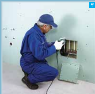
اتصال قاب دریچه
