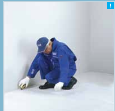
مشخص کردن محل نصب رانر کف با ریسمان رنگی
