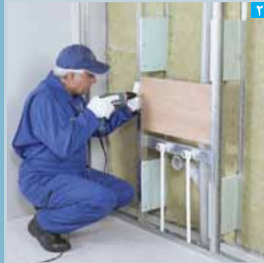
اتصال تراورس (نخته چند لایه) به قطعات نبشی L25
