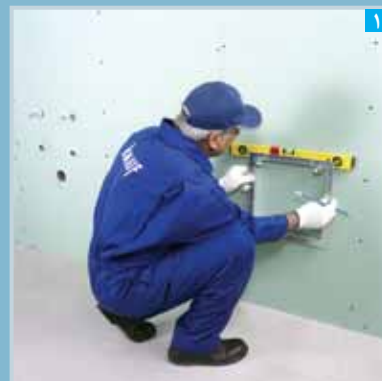
علامت گذاری محل دریچه (با استفاده از قاب دریچه)
