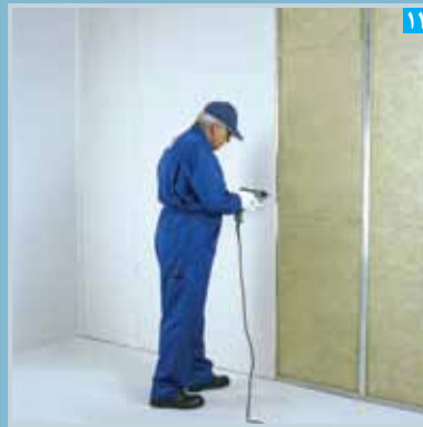
۱۱ اجرای پتل ها در طرف دیگر دیوار (پتل ها نسبت به سمت اول به صورت حصیرچین اجرا می شوند)
