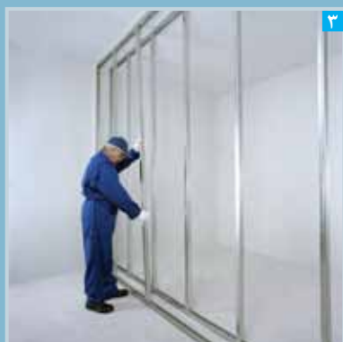
اجرای ردیف دوم استاداها
