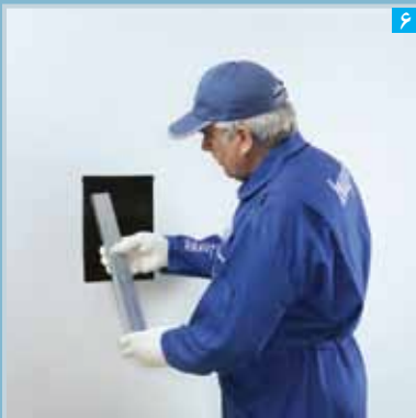
قرار دادن قطعه پروفیل در درون دیوار به منظور ایجاد زیرسازی در محل آسیب دیده
