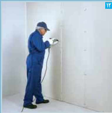
۱۲ اجرای لایه دوم پتل ها (لایه دوم نسبت به لایه اول به صورت حصیرچین اجرا می شود)
