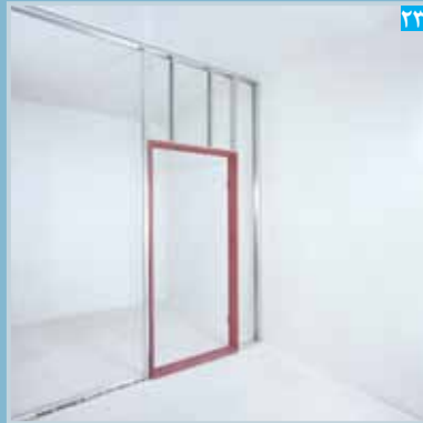
قاب بندی و تقویت بازشوی در تکمیل شده
