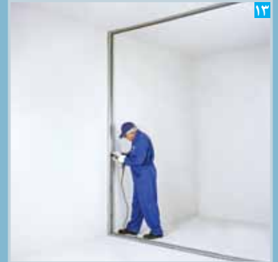
نصب استادا بر روی ساختار جانبی (سوراخ کردن استادا و دیوار)
