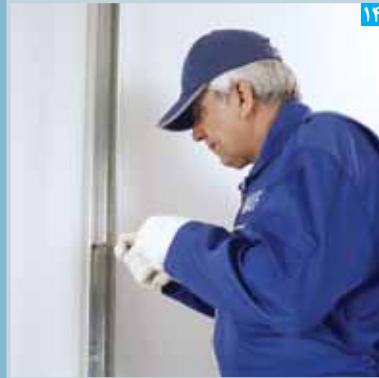
اتصال استادا به دیوار بتایی با رول پلاک
