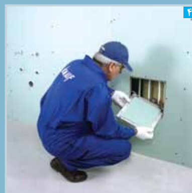
قرار دادن پنل دریچه در درون قاب
