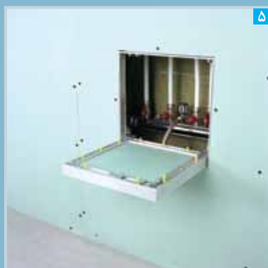
دریچه نصب شده
