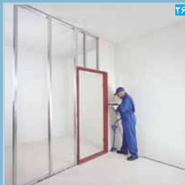
اجرای پنل اول دور چهارچوب (پنل ها به صورت L برش داده می شوند)
