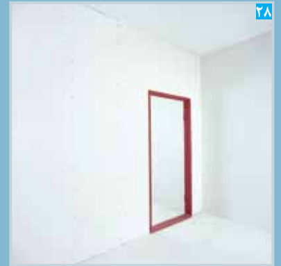
۲۸ پنل گذاری در یک سمت دیوار تکمیل شده
