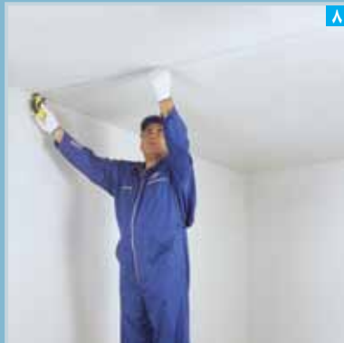
مشخص کردن محل نصب رانر سقف با ریسمان رنگی
