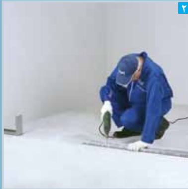
نصب رانر کف
