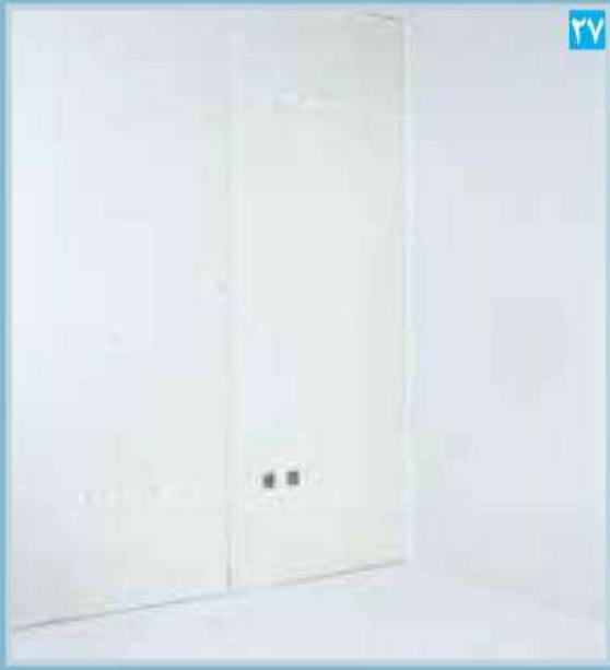
دیوار تکمیل شده (خروجی های تاسیساتی به وسیله گردبر یا اره چاقویی و سوهان ایجاد می شوند)
