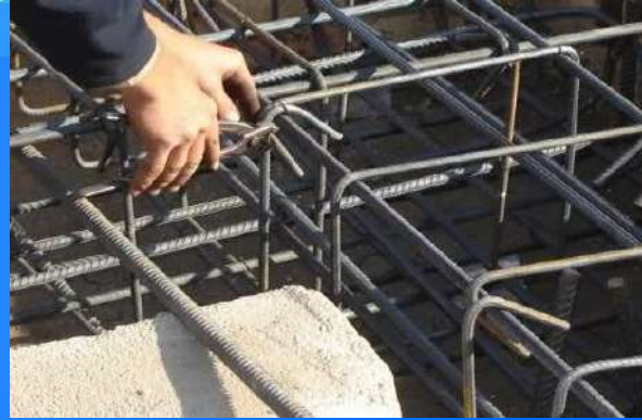
1- وصله کردن با سیم آرماتوربندی
