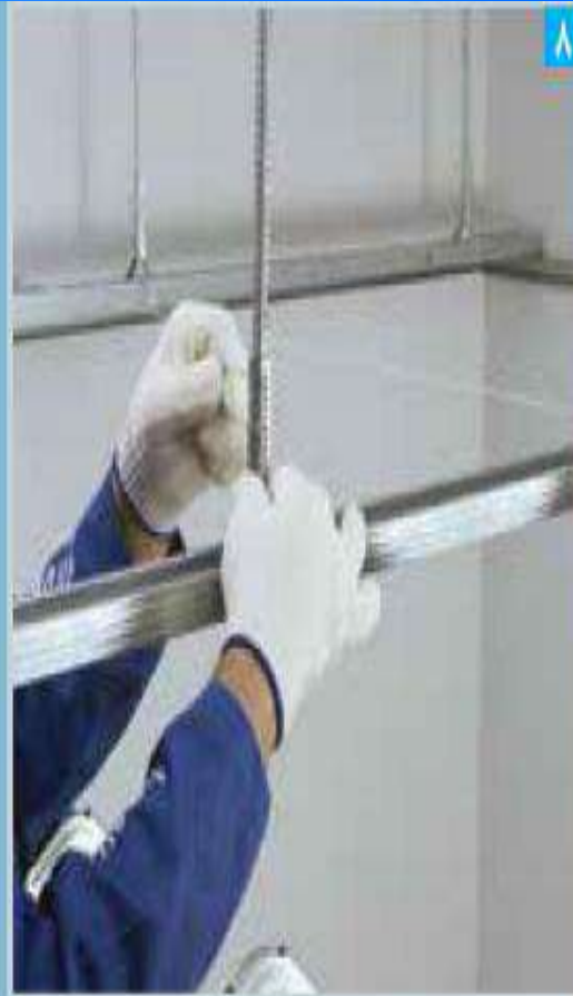
اتصال رکاب به آویز و رگلاژ سقف توسط پین
