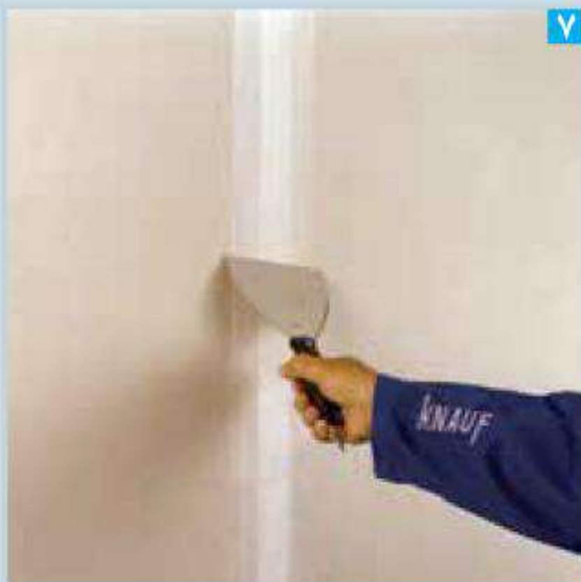
مرطوب کردن سطح نوار، با بتونه های اضافه
