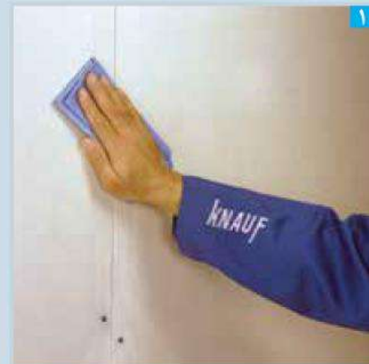
سایز کردن سطح، قبل از بتونه کاری و یا اجرای ماستیک بسیار مهم است
