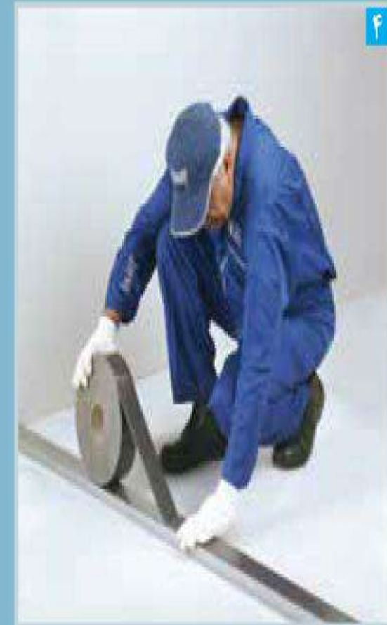
اجرای نوار عایق (یا دوردیف خمیر سیلیکون) بر پشت جان رانر کف و سقف
