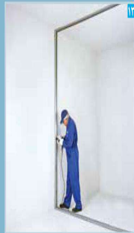
نصب استاد بر روی ساختار جانبی (سوراخ کردن استاد و دیوار)
