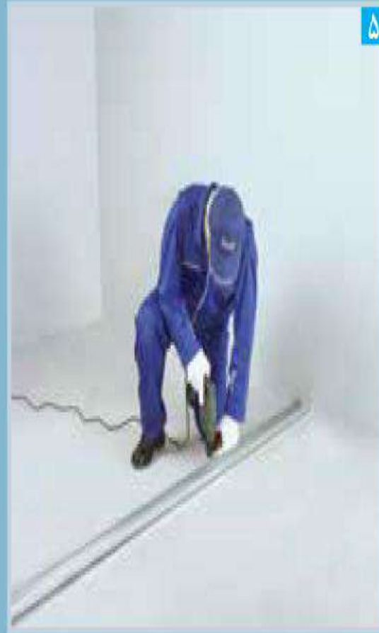
نصب رانر کف (سوراخ کردن رانر و کف)
