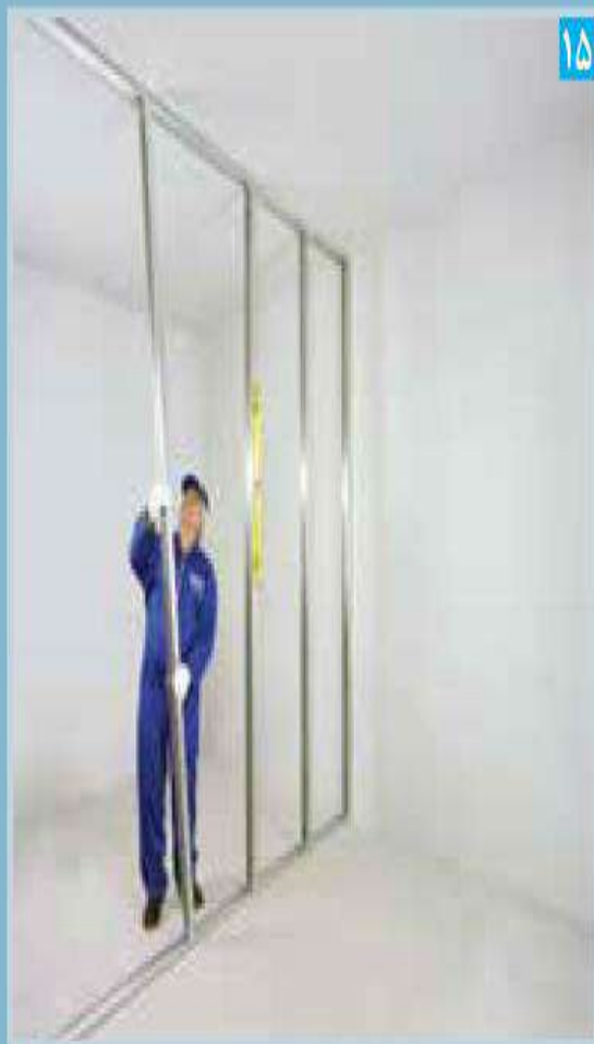
اجرای استاده‌ها (به صورت شاقولی)
