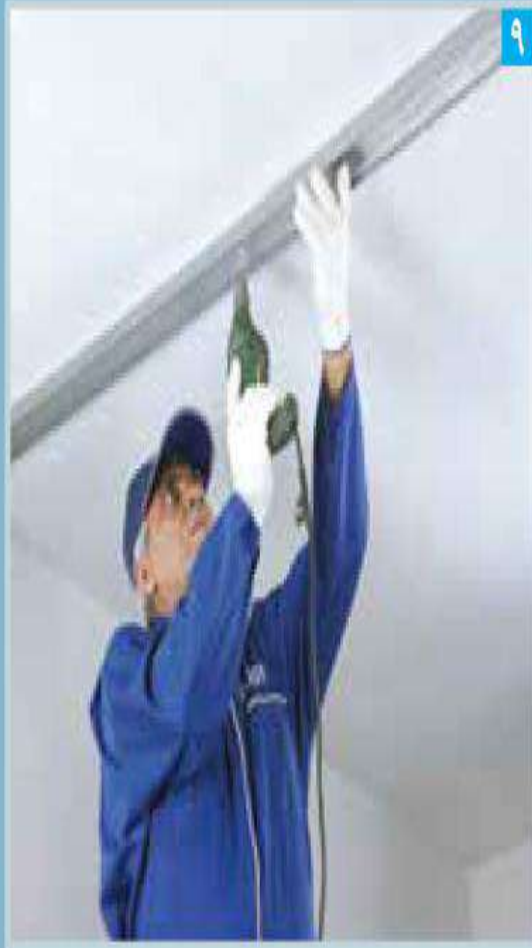
نصب رانر سقف (سوراخ کردن رانر و سقف)
