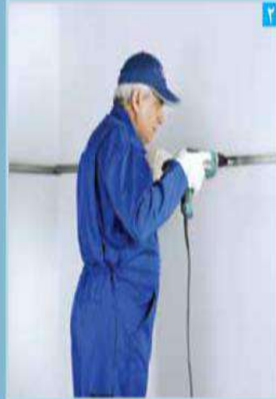
نصب سازه تراز
