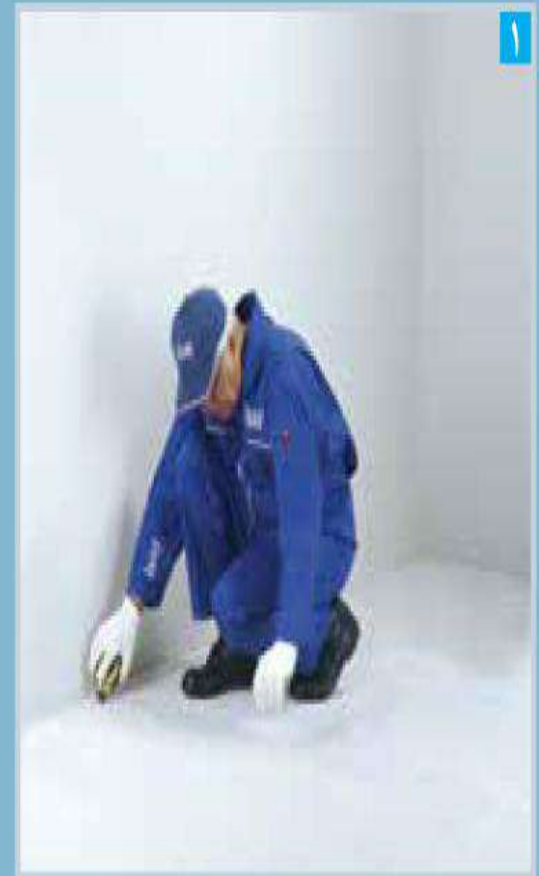
مشخص کردن محل نصب رانر کف با ریسمان رنگی
