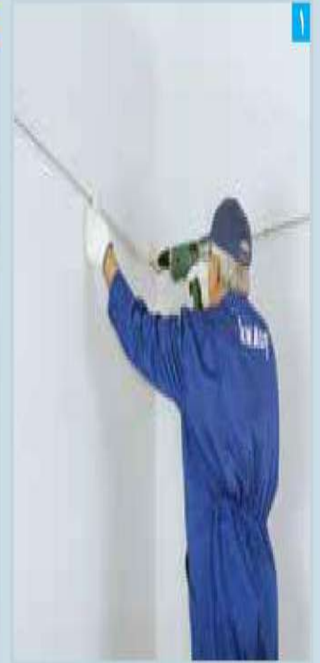
نصب سازه تراز پس از تعیین خط تراز سقف
