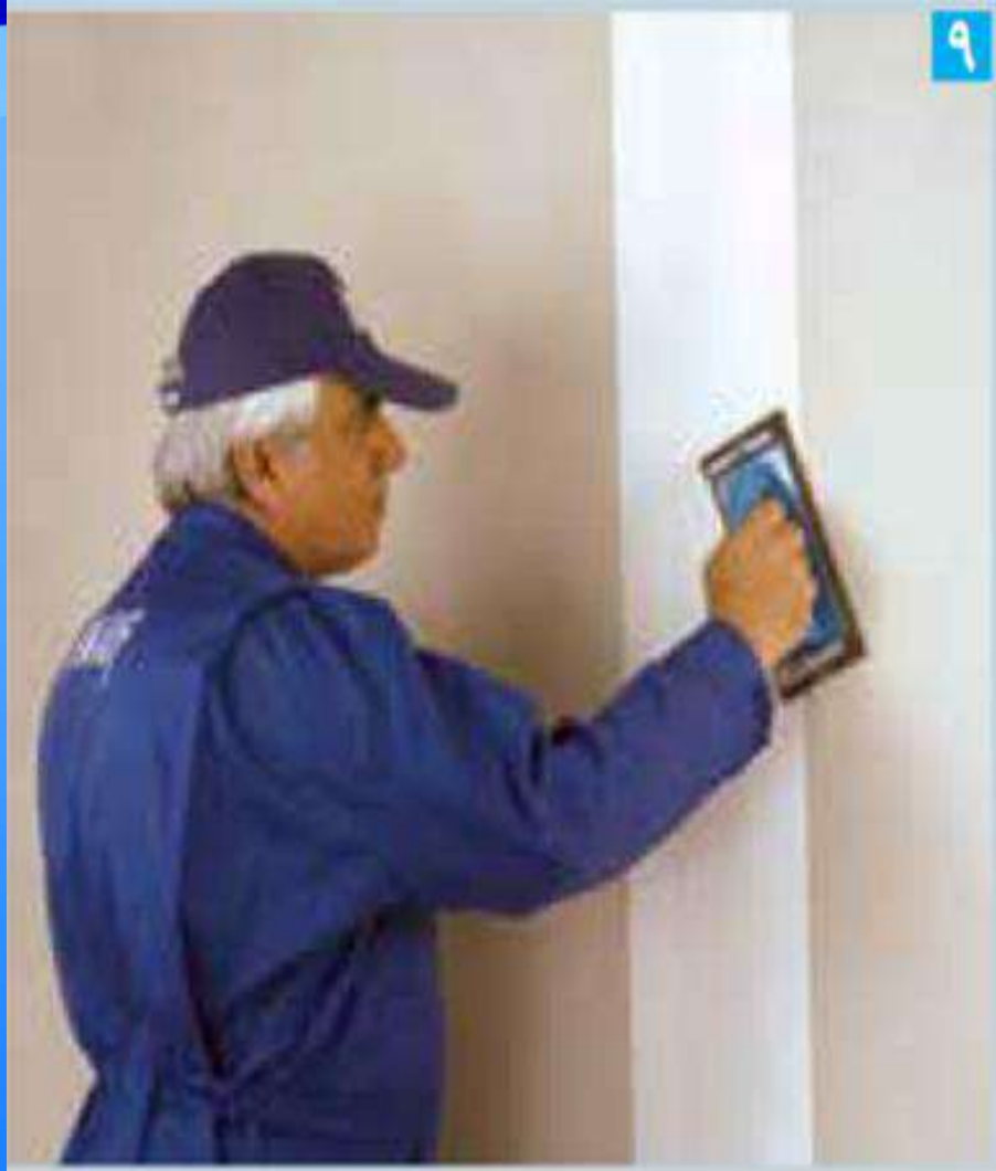
پرداخت سطح بتونه خشک با ساب ماله ای
