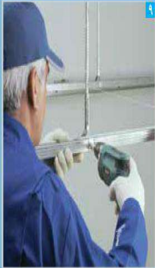
اتصال سازه باربر به رکاب توسط پیچ LN
