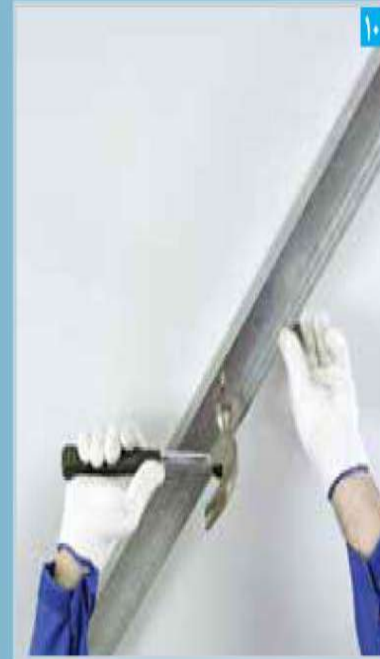
اتصال رانر به سقف با رول پلاگ
