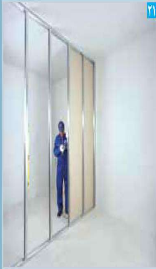
اجرای پنل ها در یک طرف دیوار
