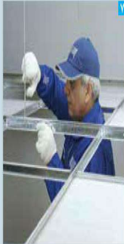
تنظیم ارتفاع سقف
