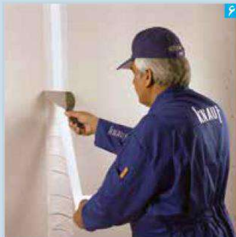
قرار دادن نوار درزگیر بر روی بتونه
