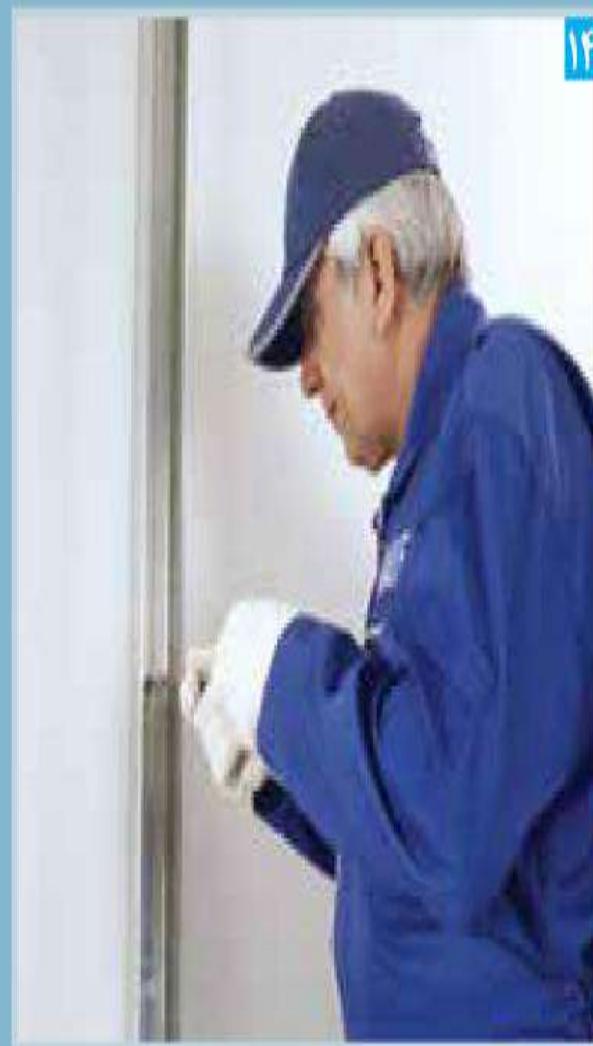
اتصال استاد به دیوار بنایی با رول پلاگ
