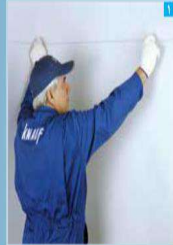
مشخص کردن محل نصب سازه تراز با ریسمان رنگی
