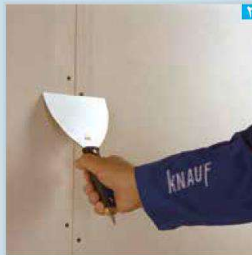
بررسی بیرون زدگی پیچ ها با کاردک
