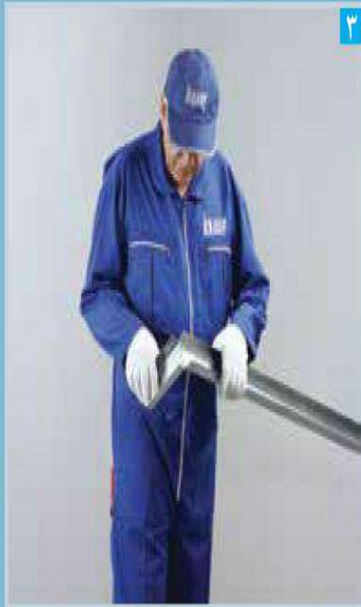
پس از برش بال ها، رانر خم و راست شده تا از محل جان برش بخورد
