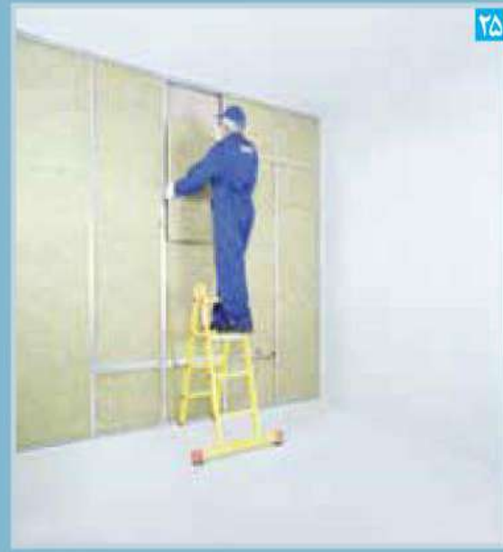
اجرای عایق پشم معدنی در فواصل بین استادها (توجه شود که تاسیسات در مرحله قبل اجرا شده است)
