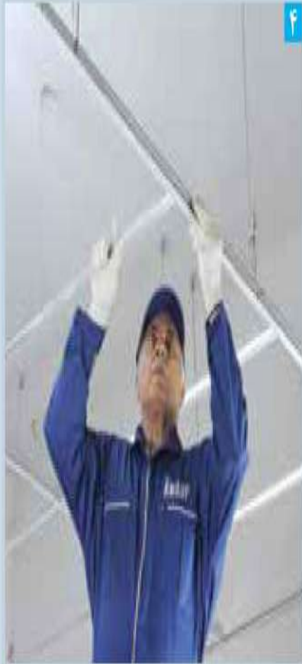
اجرای سازه‌های فرعی T1200
