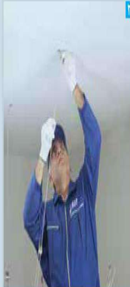
اتصال اویز به سقف اصلی با استفاده از قطعه HT90
