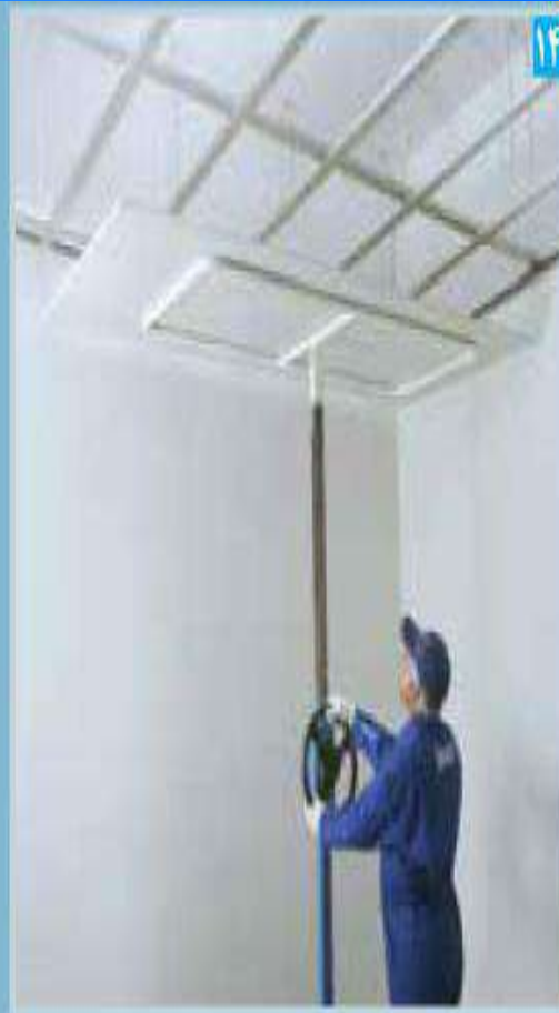
استقرار پتل با استفاده از بالابر
