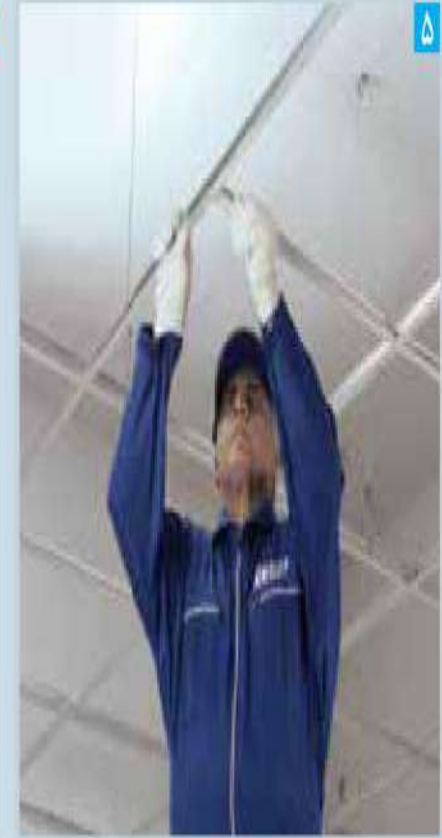
اجرای سازه‌های فرعی T600
