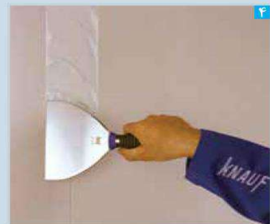
اجرای لایه بتونه در محل درز (کاردک در جهت عمود بر درز کشیده می شود تا بتونه کاملا در درز نفوذ کند)
