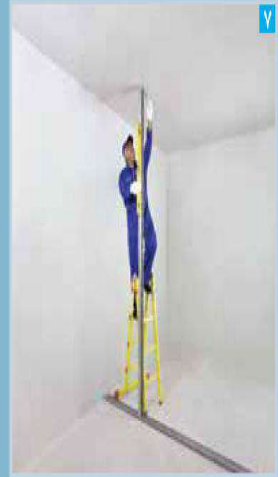
انتقال تصویر رانر کف به سقف (با استفاده از استاد و تراز)
