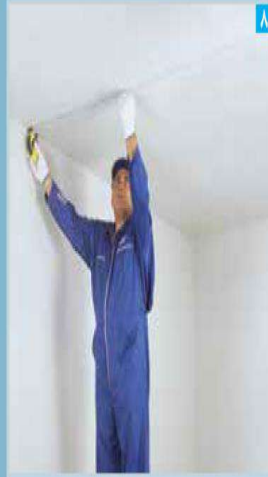
مشخص کردن محل نصب رانر سقف با ریسمان رنگی
