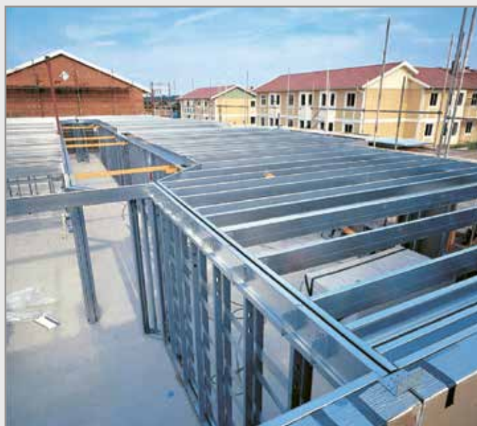
شکل ۲۹: سیستم سازه فولادی سبک (LSF)
