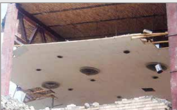
شکل ۱۵: اجرای سقف‌های کاذب با روش سنتی
