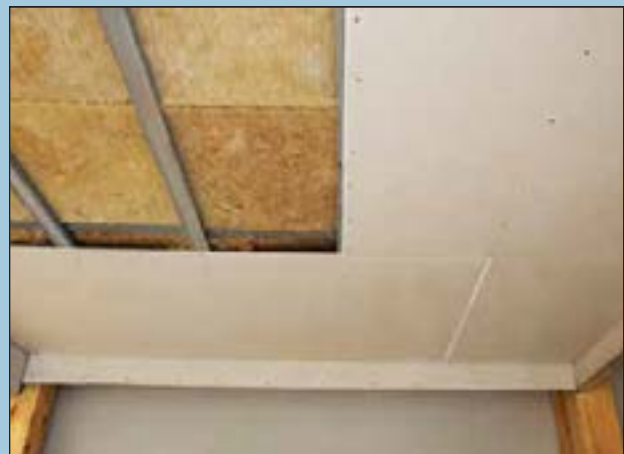
عایق کاری صوتی سقف ساختمان با سقف کاذب کناف
