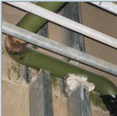
قطع سازه‌های عمودی دیوار به جهت عبور لوله‌های تاسیسات
