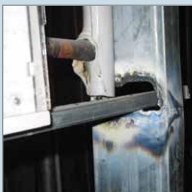
برش سازه با ابزار نامناسب
