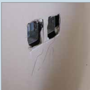
برش نامناسب پنل
