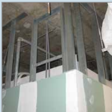
عدم امتداد یافتن پنل‌ها تا سقف اصلی
