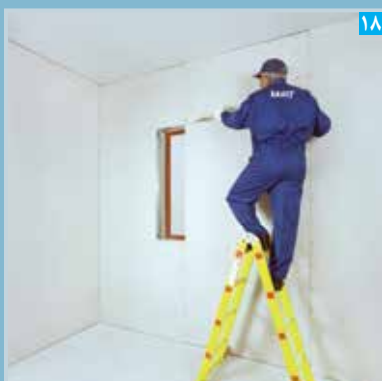
۱۸ برش پنبل به صورت 'C' شکل (با استفاده از اره)
