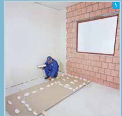
۱ اجرای چانه های پرفلیکس بر پشت پنل
