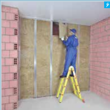
۶ اجرای عایق پشم معدنی (توجه: در فاصله میان استادها)
