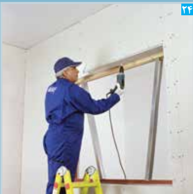
اتصال پنل نواری به رانر قاب بندی فوقانی
