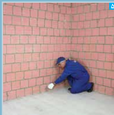
۵ مشخص کردن محل نصب رانر کف با ریسمان رنگی
