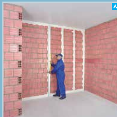
بررسی تراز و تنظیم بودن کرم نصب شده با استفاده از شمشه و تراز
