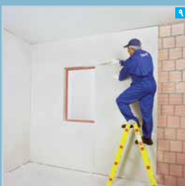
۹ برش پنل به صورت 'C' شکل (با استفاده از اره)
