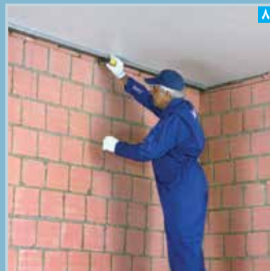
۸ مشخص کردن محل نصب براکت ها بر روی دیوار زمینه
