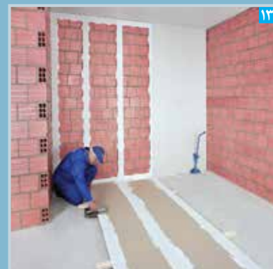
لایه نواری فوگن فولر را می توان بر پشت پنل ها اجرا نمود
