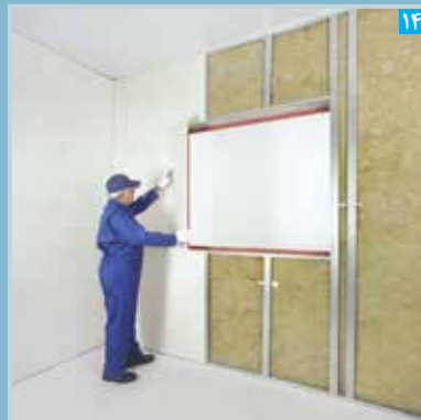
۱۴ برش پنل با استفاده از تیغ برش
