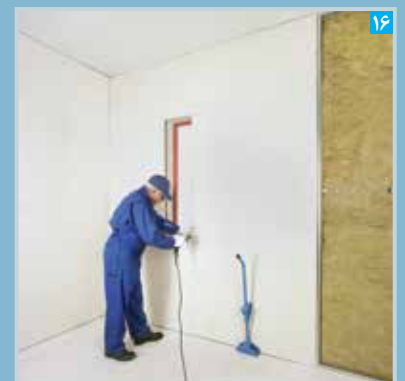
۱۶ نصب پنل بر روی زیرسازی
