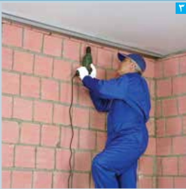
۳ نصب رانر سقف
