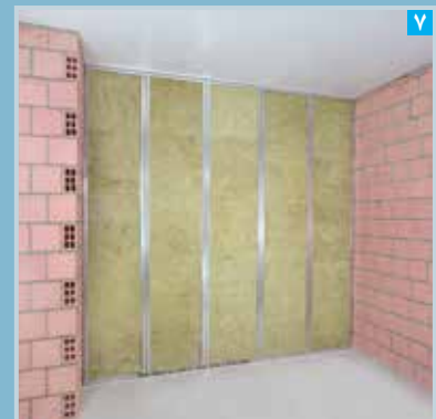
۷ لایه عایق تکمیل شده
