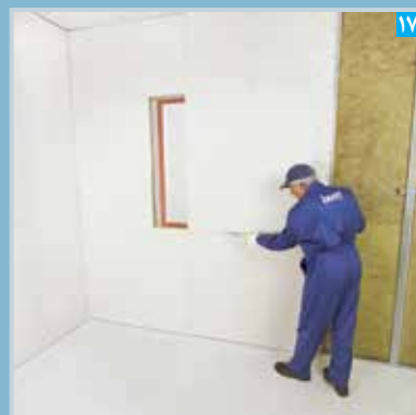
۱۷ برش پنل به صورت 'C' شکل (با استفاده از اره)
