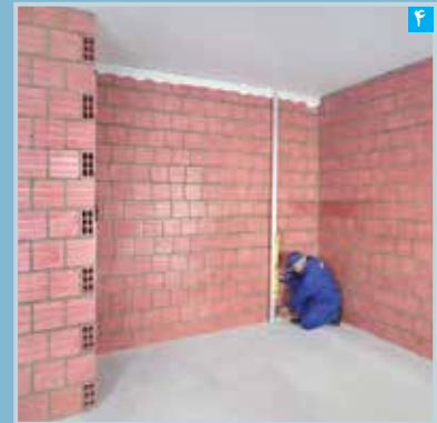
مشخص کردن محل نصب کرم پایین با استفاده از شمشه و تراز
