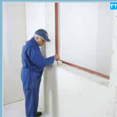
اجرای پرایمر بر روی سطح پتل
