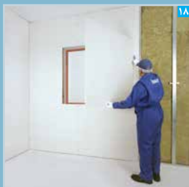
۱۸ برش پنل به صورت 'C' شکل (با استفاده از تیغ برش)
