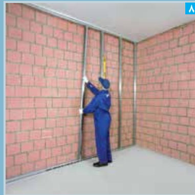
اجرای استاداها (به صورت شاقولی)
