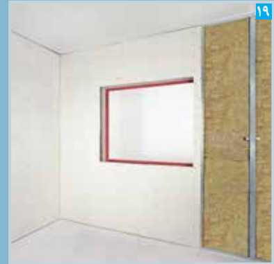
۱۹ پوشش کاری تکمیل شده در ناحیه بیرونی بازشوی پنجره
