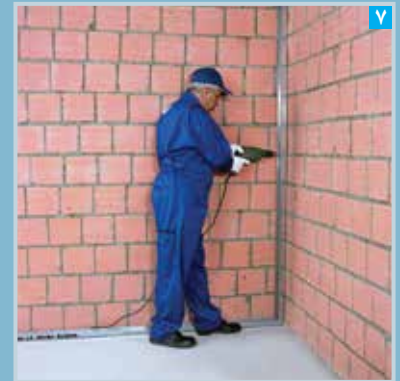
نصب اولین استاد بر روی ساختار جانبی
