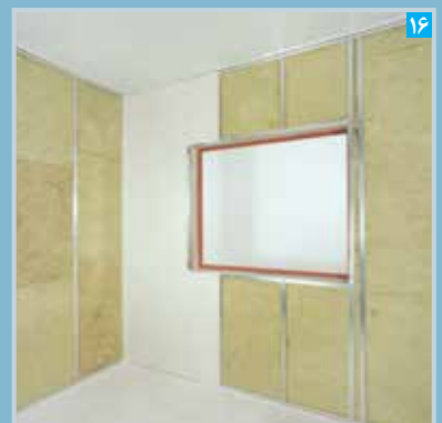
۱۶ در محل بازشوی پنجره، برش پنبل به صورت 'C' شکل صورت می گیرد
