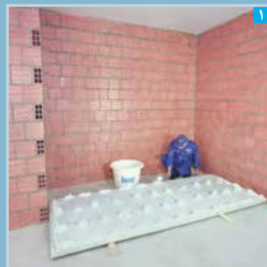
اجرای چانه های پرلیفیکس بر پشت پنل مرکب PS
