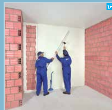
نصب و تنظیم پنل، با پنل نصب شده مجاور
