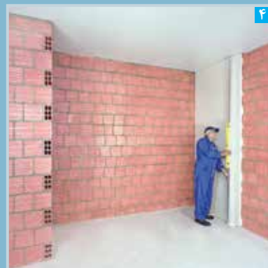
بررسی تراز و تنظیم بودن پنل نصب شده با استفاده از شمشه و تراز
