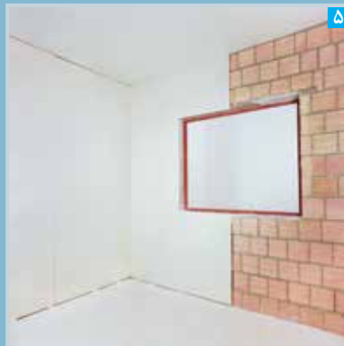
۵ در محل بازشوی پنجره، برش پنل به صورت 'C' شکل صورت می گیرد
