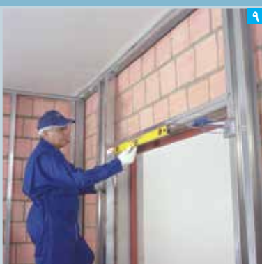
۹ تنظیم رانر قاب بندی فوقانی به وسیله تراز
