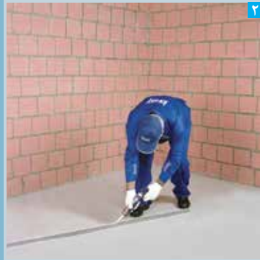
۲ اجرای دو ردیف خمیر درزبند (یا نوار عایق) بر پشت سازه های هادی کف و سقف
