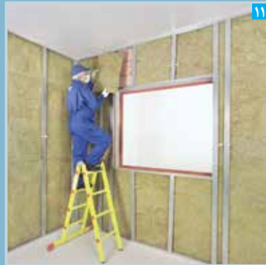
۱۱ اجرای عایق پشم معدنی
