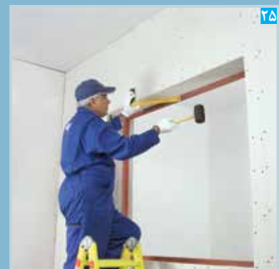
تنظیم پنل نواری (گونیا کردن)
