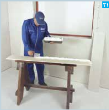
اجرای پرل‌فیکس بر پشت پنل نواری (به اجرای یکپارچه پرل‌فیکس توجه شود)
