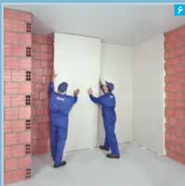
استقرار پنل بر روی دیوار زمینه
