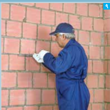
۹ نصب براکت بر روی دیوار زمینه
