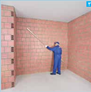
شمشه گذاری به صورت مایل بر روی دیوار زمینه، جهت بررسی ناهمواری در طول دیوار
