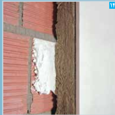
ضخامت چانه پرفیکس پس از نصب و فشردن پنل باید حداقل ۵ میلیمتر باشد
