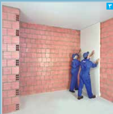
استقرار پنل بر روی دیوار زمینه
