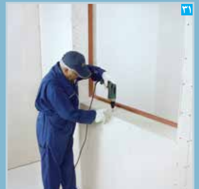
اتصال پنل نواری به رانر قاب بندی تحتانی
