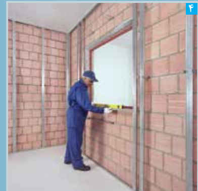
تنظیم سازه قاب بندی به وسیله تراز
