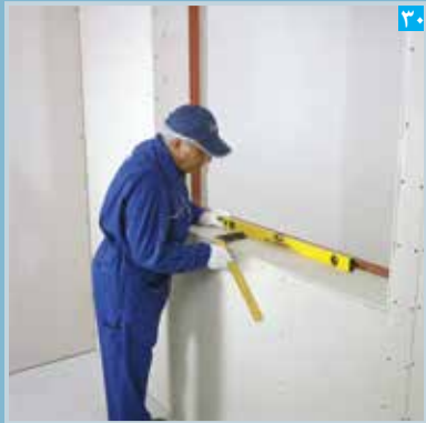
تنظیم پنل نواری (گونیا و تراز کردن)
