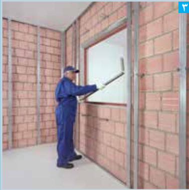
استقرار سازه قاب بندی تحتانی (به جهت خم ها توجه شود)
