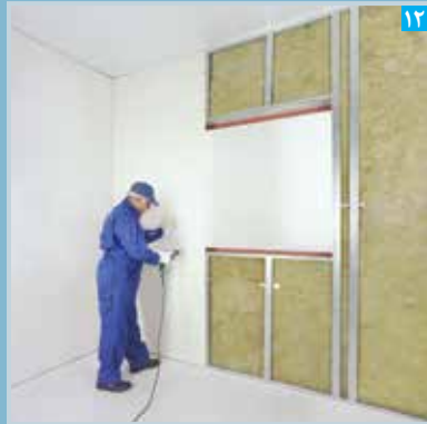
۱۳ نصب پنل بر روی زیرسازی
