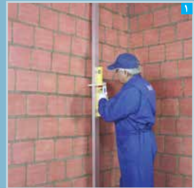
اندازه گیری میزان ناهمواری دیوار
