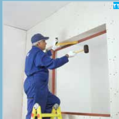
۲۳ تنظیم پنل نواری (گونیا کردن)
