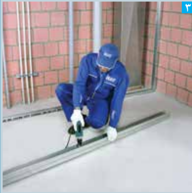
۳ اجرای استادهای دوتایی
