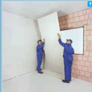
۲ استقرار پنل بر روی دیوار زمینه
