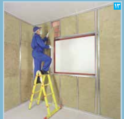
۱۳ اجرای عایق پشم معدنی
