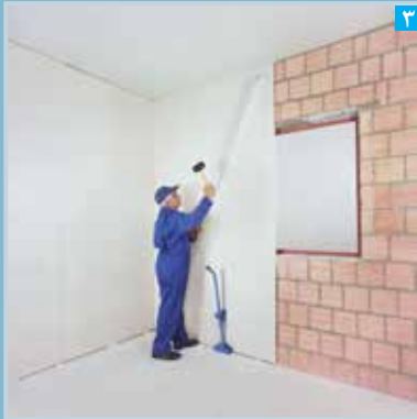
۳ نصب و تنظیم پنل بر روی دیوار زمینه
