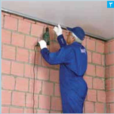
۳ نصب سازه هادی سقف
