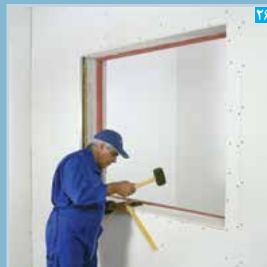
۲۶ تنظیم پنل نواری (گونیا کردن)
