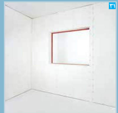
پوشش کاری تکمیل شده در ناحیه بیرونی و درونی بازشوی پنجره
