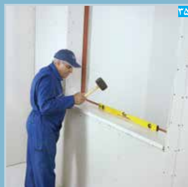
نصب و تنظیم سنگ کف پنجره
