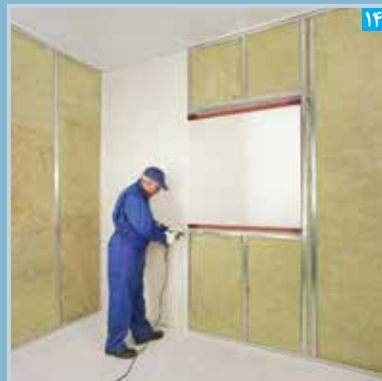
۱۴ نصب پنبل بر روی زیرسازی
