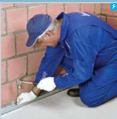
۶ نصب رانر کف
