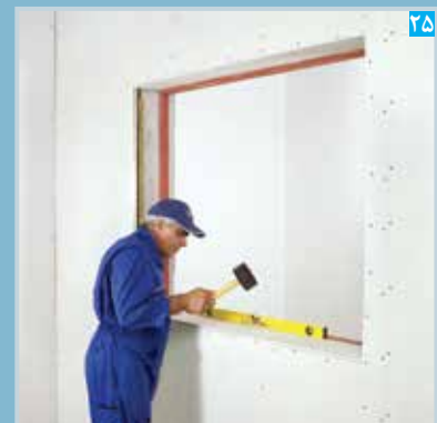
۲۵ تنظیم پنل نواری (تراز کردن)
