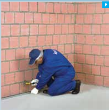
۶ نصب سازه هادی کف
