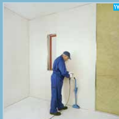
۱۷ نصب پنبل بر روی زیرسازی
