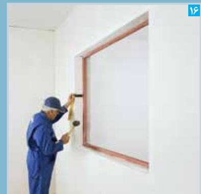
نصب و تنظیم پنل نواری
