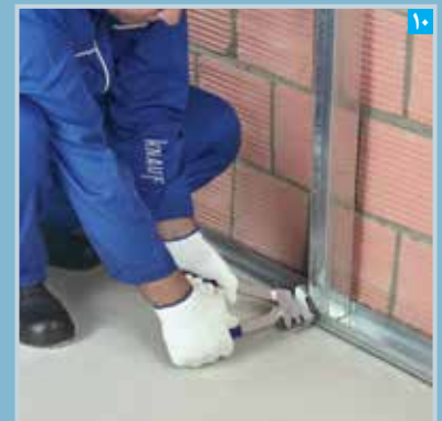
اتصل و تثبیت استاداها به رانرها (به وسیله پانچ، پرچ یا پیچ)
