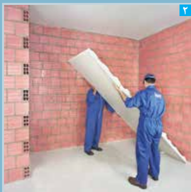
پنل به سادگی توسط دو نفر قابل بلند کردن است
