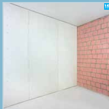
لایه اول پنل ها تکمیل شده (دیوار پوششی W625)
