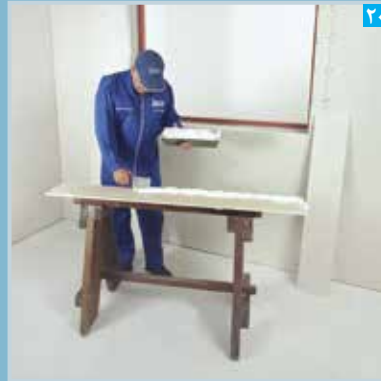
۲۰ اجرای پرلفیكس بر پشت پنل نواری (برای پوشش کاری ناحیه داخلی دور بازشوی پنجره)
