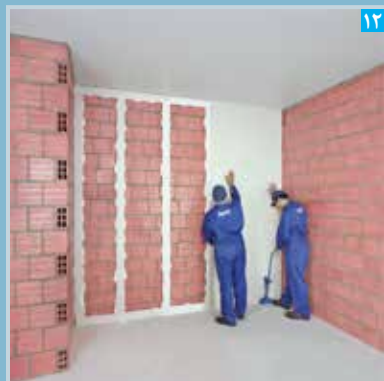
نصب پنل با استفاده از جک نگهدارنده
