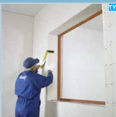
تنظیم پنل نواری (گونیا کردن)
