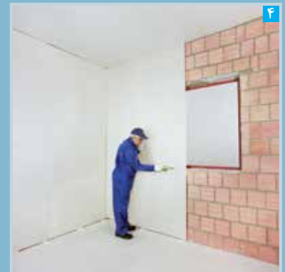
۴ برش پنل با استفاده از اره
