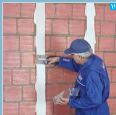
اجرای لایه فوگن فولر بر روی کرم ها با استفاده از ماله دندانه دار
