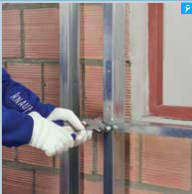
۶ اتصال رانر قاب بندی تحتانی به استاد به وسیله پانچ، برچ یا پیچ (به جهت برش ۴۵ درجه توجه شود)
