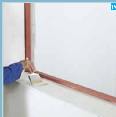
اجرای پرایمر بر روی سطح پنل
