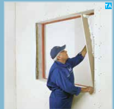
استقرار پتل نواری در ناحیه داخلی دور بازشوی پنجره (به اجرای یکپارچه پرفلیکس توجه شود)
