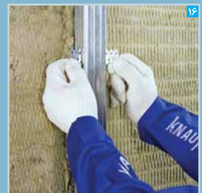
۱۶ خم کردن طول اضافه بال های برکت (توجه: لایه عایق در پشت سازه ها قرار می گیرد)
