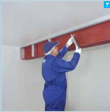
۳ اجرای سازه های قائم
