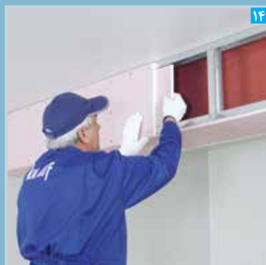
اتصال پنل پشت بند درز به پنل جانبی
