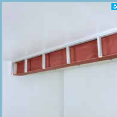
۵ سازه های فوقانی و قائم تکمیل شده
