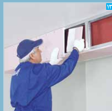
استقرار پنل پشت بند درز
