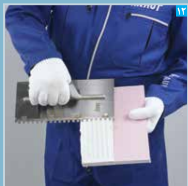
اجرای فوگن فولر بر روی نیمه از پنل پشت بند درز (با استفاده از ماله دندانه دار)
