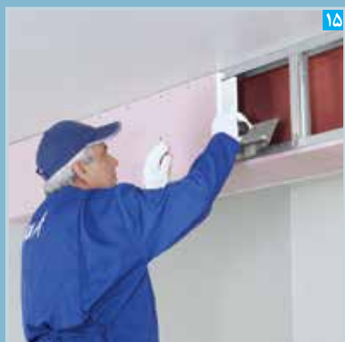
اجرای فوگن فولر بر روی نیمه دیگر پنل پشت بند درز (پس از خشک شدن فوگن فولر نیمه اول)
