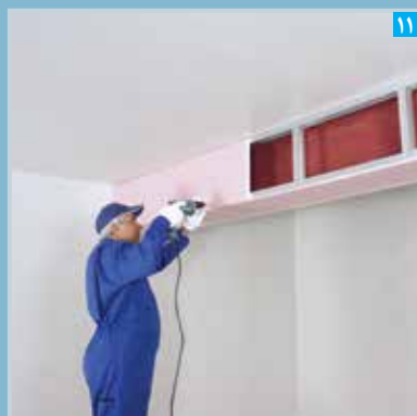
اجرای پنل جانبی
